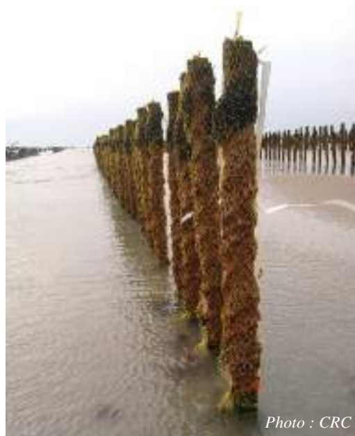
Figure 28 : Dégâts causés par des eiders
